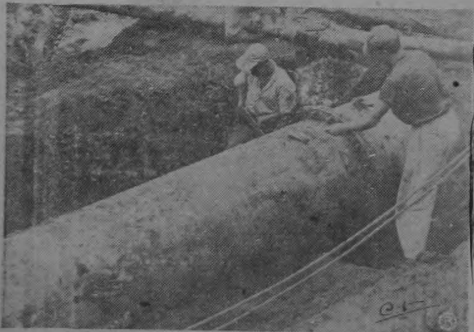
Los trabajadores josefinos unen dos tubos ya colocados en la obra.
